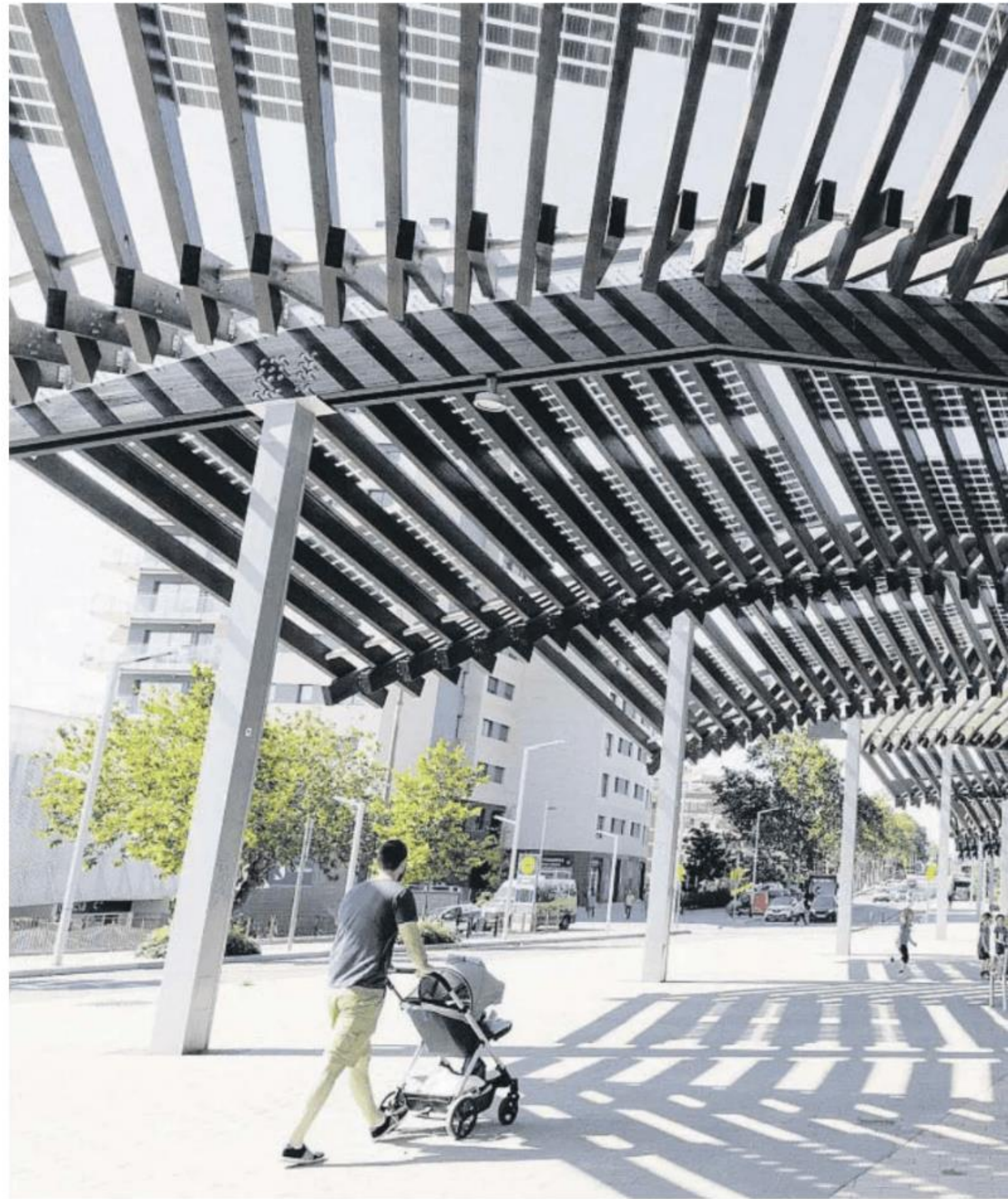
Arriba, personas bajo la pérgola que cubre la Ronda de Dalt. Abajo, el depósito subterráneo de retención de aguas pluviales del parque Joan Miró
